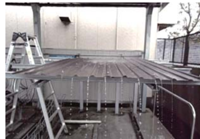
■散水状況(ガルバリウム鋼板)
